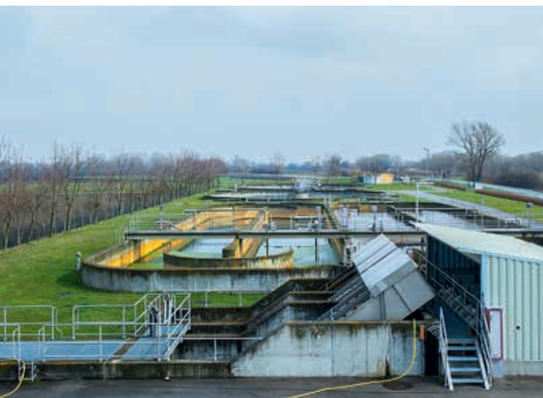
Im Dienste des ökologischen Gleichgewichts: Das in der Kläranlage Nickelsdorf gereinigte Wasser fließt wieder in die Leitha.
