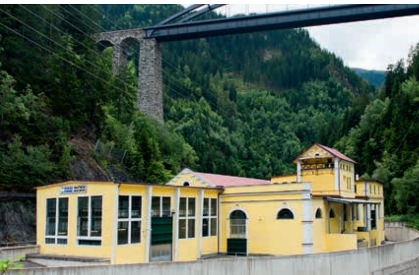
Aus diesem Wasserkraftwerk an der Rosanna bezieht das Karbidwerk Landeck seinen Strom.
