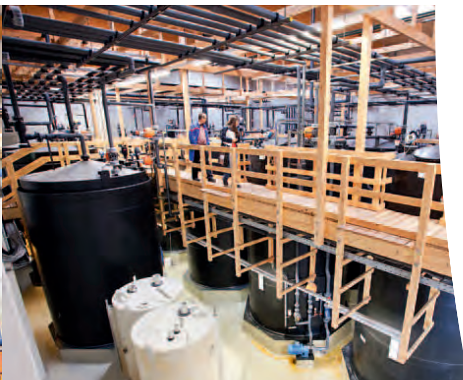
Holztreppen zwischen den Tanks trotzen den Säuredämpfen besser als Nirosta.
