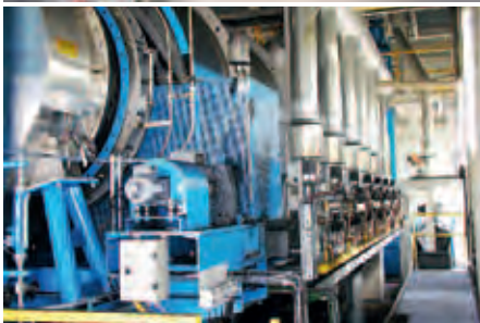
Die beiden Reaktivierungsanlagen der Donau Carbon in Frankfurt (oben) und Pischelsdorf (unten)
