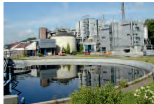
Der Zweckverband Klärwerk Steinhäule (ZVK) in Baden Württemberg (D): Hier wird Aktivkohle seit 2003 getestet.
